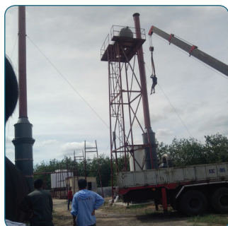
Lắp đặt hệ thống ống hơi và Thông Gió trong Công nghiệp
