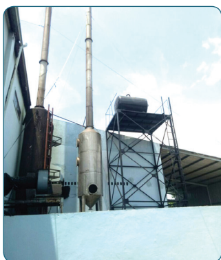
Tháp dầu lắp và xử lý theo lò dầu 2 tấn
